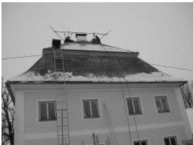
Am 20. September 2005 erfolgte der „Startschuss“ der Renovierungsarbeiten. Obwohl sozusagen kein Stein auf dem anderen blieb konnte bereits im November das Gebäude wieder beheizt werden und auch das Dach war zu diesem Zeitpunkt bereits saniert und neu mit Holzschindeln eingedeckt.
